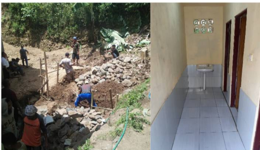
Ouders helpen mee bij het leggen van de fundering voor het school toiletgebouw
